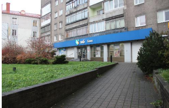
Фотография 3.1. Внешнее состояние объекта
