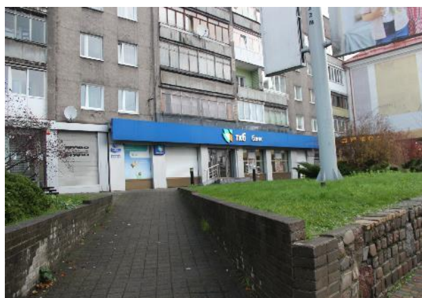
Фотография 4. Внешнее состояние объекта
