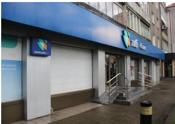
Фотография 11. Внешнее состояние объекта
