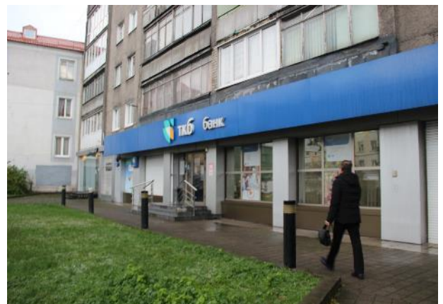
Фотография 12. Внешнее состояние объекта
