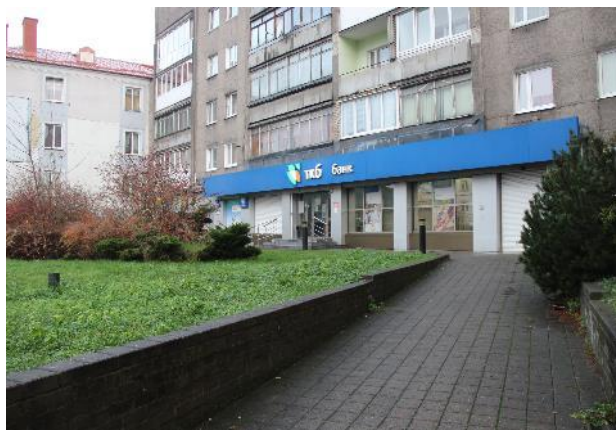
Фотография 1. Внешнее состояние объекта
