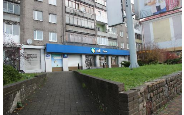
Фотография 3.2. Внешнее состояние объекта
